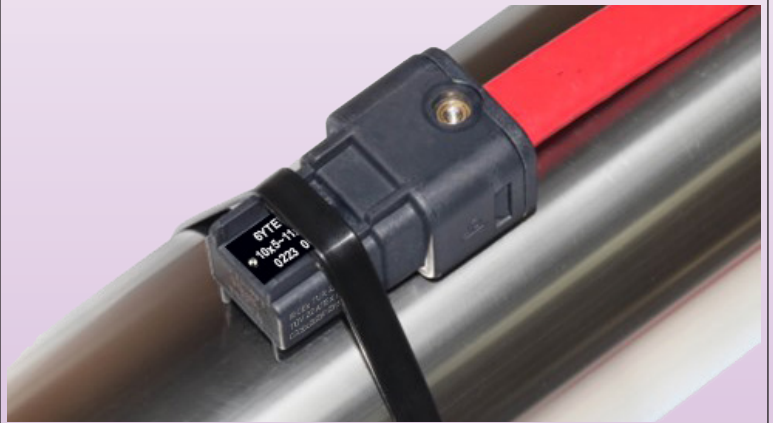
Après insertion du câble, verrouillage et montage sur tuyauterie
